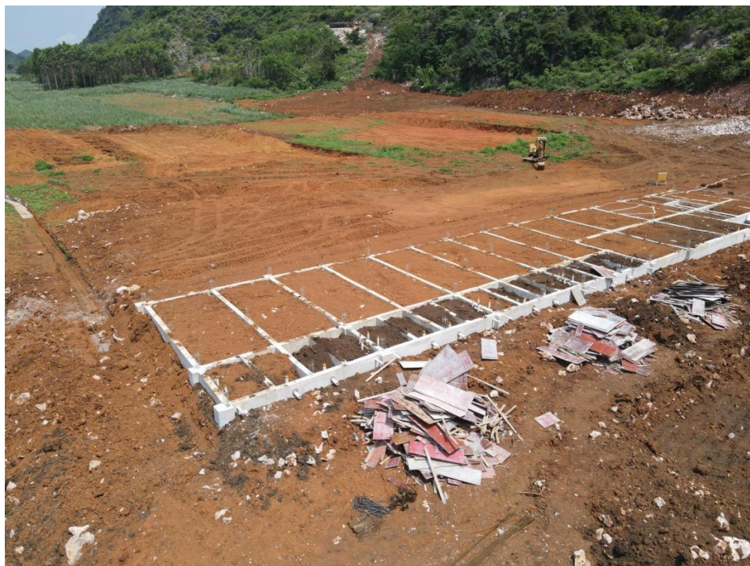
图 3.1-2 项目施工期照片（2025 年 7 月）
