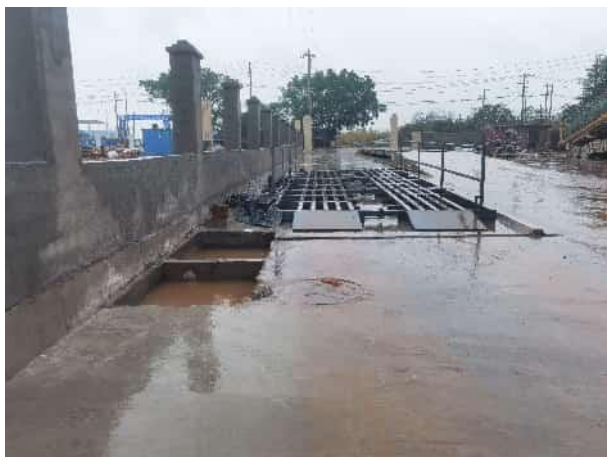
洗车平台和沉沙池
