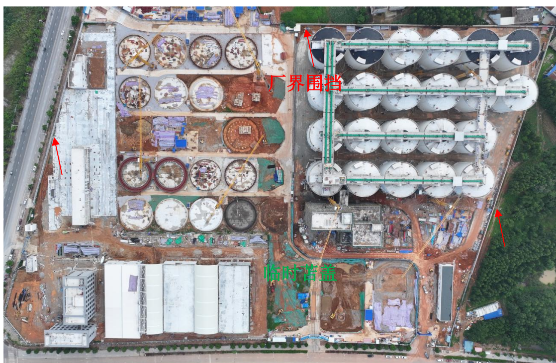
图3.6-1施工厂界围挡和临时苫盖
