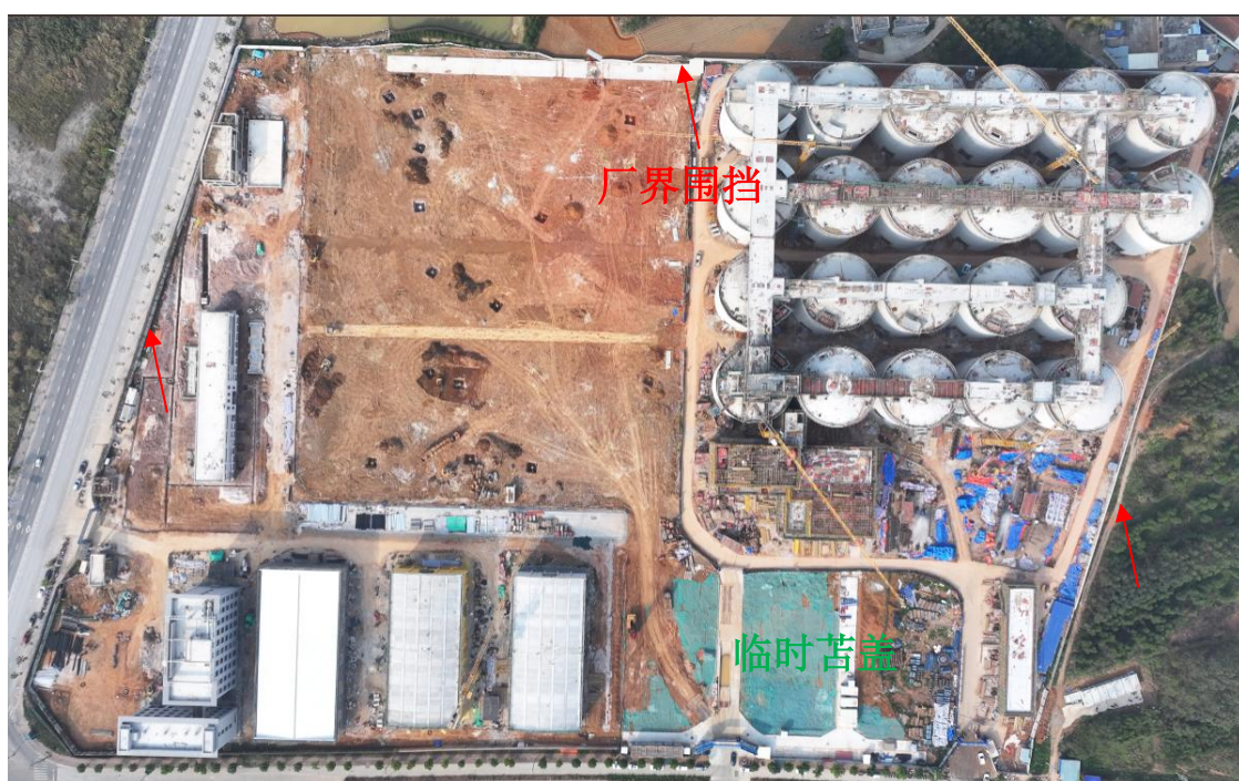
图3.6-1施工厂界围挡和临时苫盖
