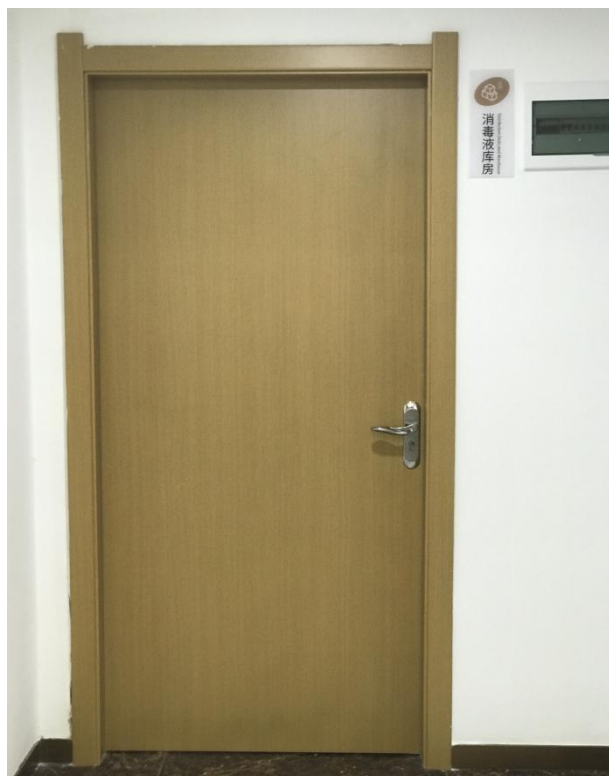
消毒液库房（次氯酸钠消毒液存放点）
