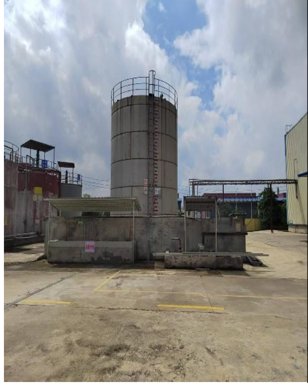
氨水储罐区+围堰
