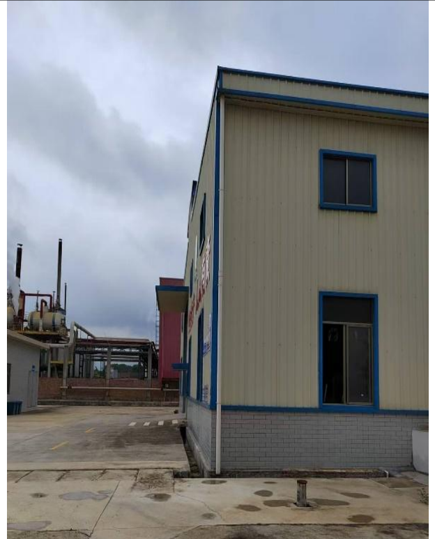
厂区内雨水收集沟
