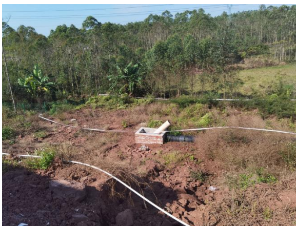
建好后埋于地下的污水收集发酵池（兼初期雨水池）、暂存池（兼事故应急池）
