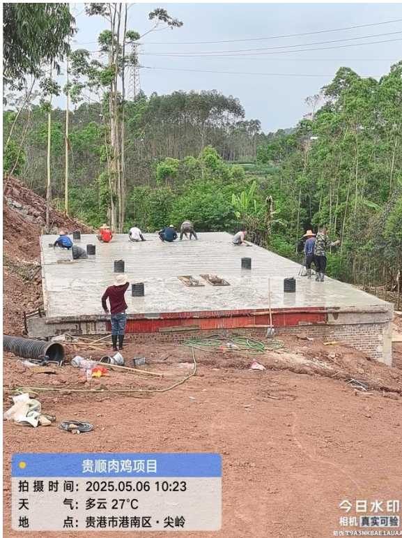
污水收集发酵池（兼初期雨水池）、暂存池（兼事故应急池）建设过程照片（现已建设完成埋于地下）
