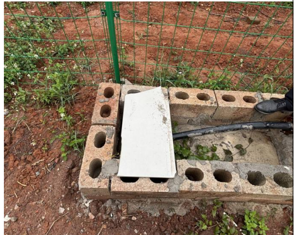
场区内地下水井
