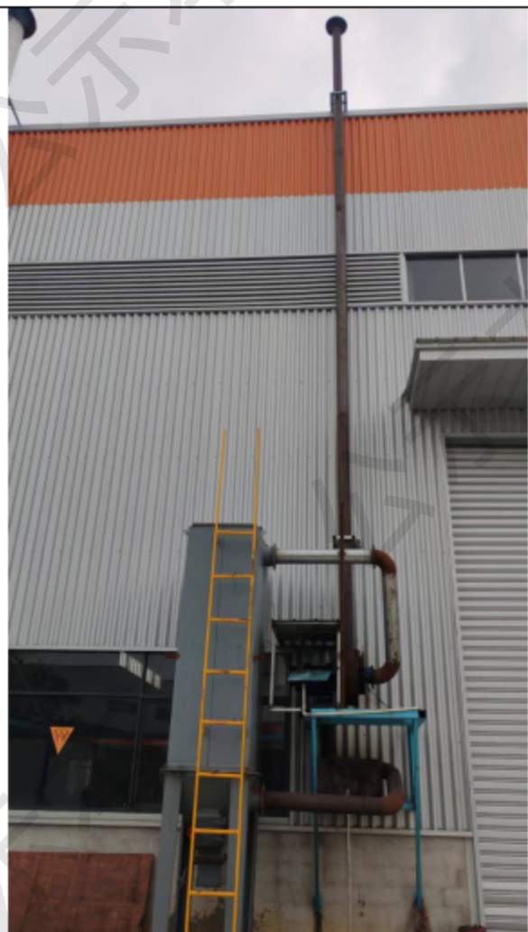
喷漆烘干工序生物质成型颗粒燃料燃烧废气布袋除尘+DA003 排气筒
