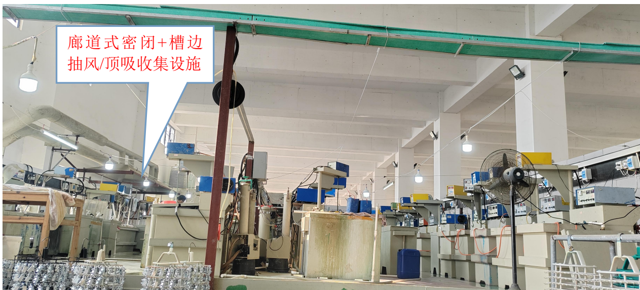
5号厂房第3层挂镀镍、镀白铜锡生产线
