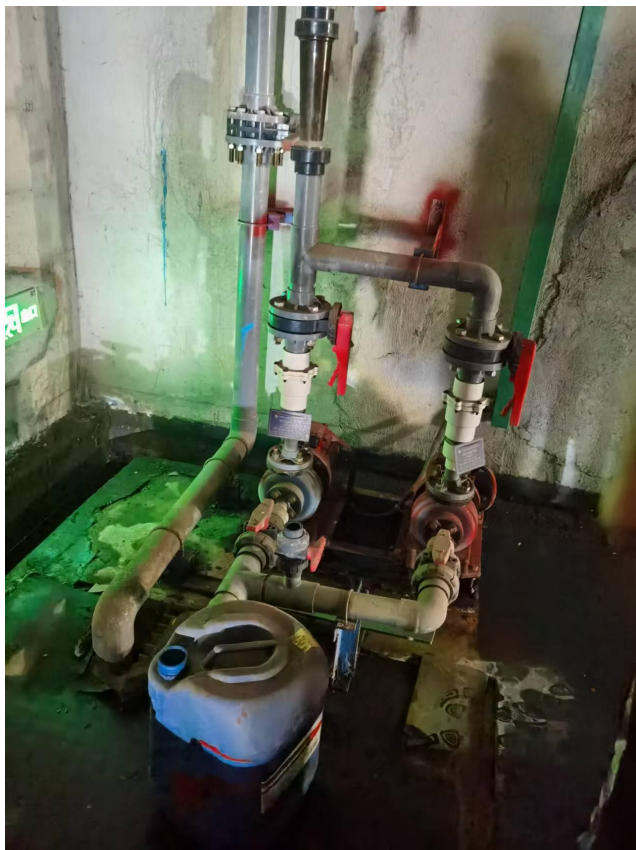
事故池进水管和出水管
