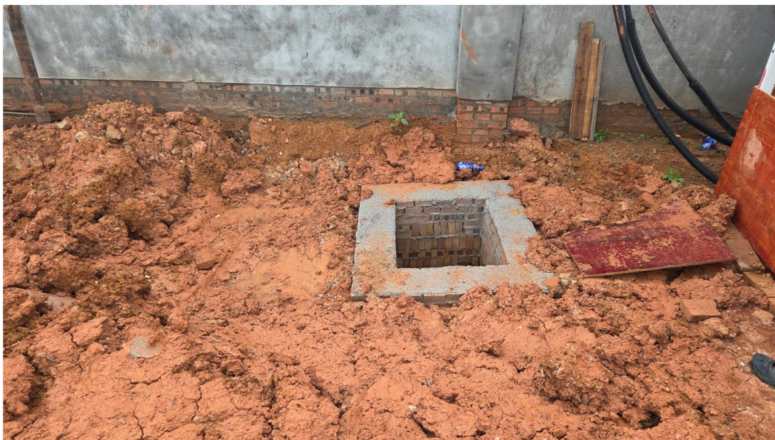
图4-1 管道开挖回填区裸露，临时苫盖措施不完善
