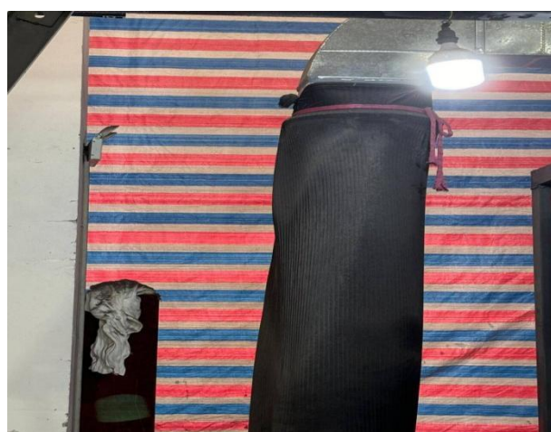
抓毛、磨毛和剪毛工序废气处理设施（布袋除尘）
