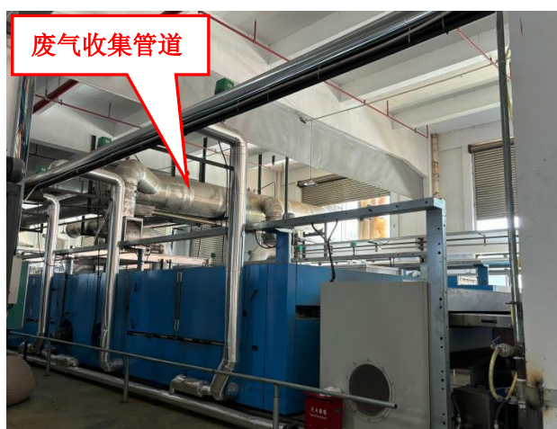
定型车间及废气收集管道
