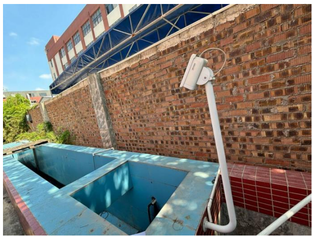
废水在线监控及在线监测设备
