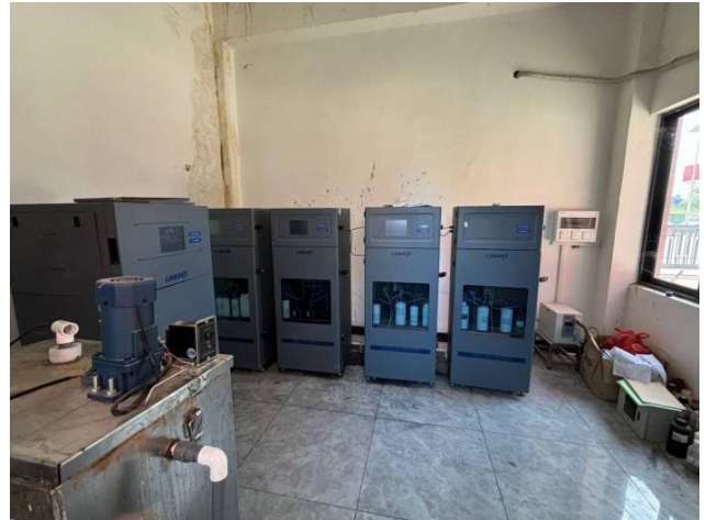
废水在线监控及在线监测设备
