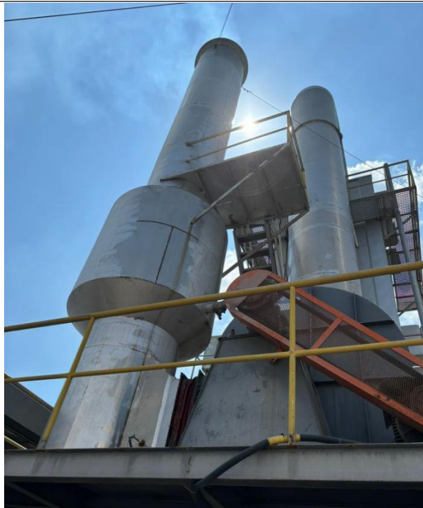
定型废气处理措施（水喷淋-湿式高压静电+1#排气筒）
