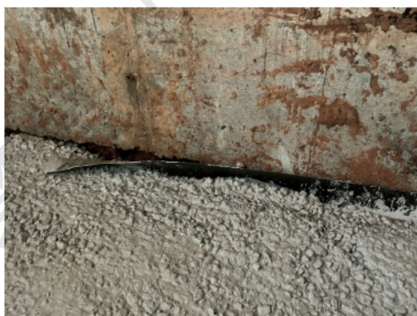
一、二、三线替代原料仓内部（硬化、防渗处理）
