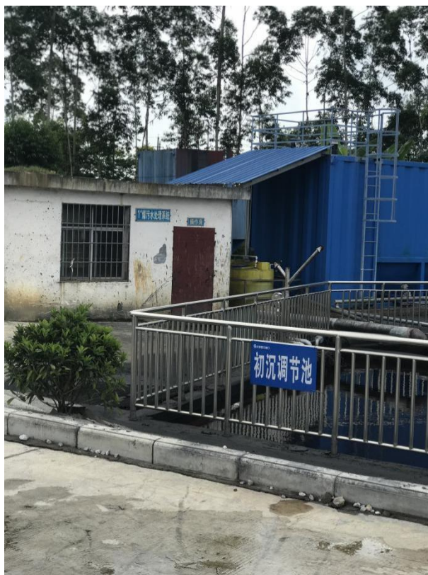
1#煤污水处理站(依托广西贵港北港国际集装箱码头有限公司处理)
