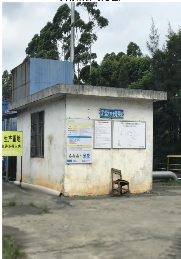
3#煤污水处理站(依托广西贵港北港国际集装箱码头有限公司处理)
