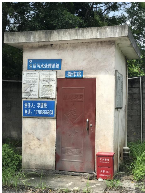
生活污水处理站(依托广西贵港北港国际集装箱码头有限公司处理)
