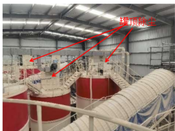
搅拌楼内现状
