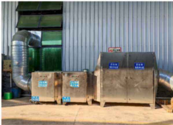
注塑、制线废气处理设施（活性炭+UV 光氧）
