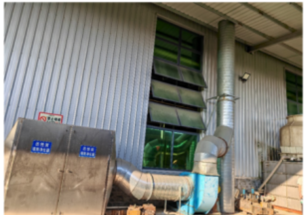
注塑、制线废气排气筒
