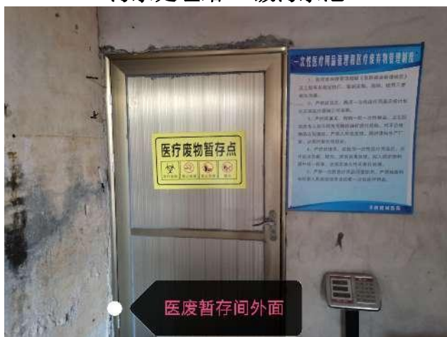
医疗废物暂存间
