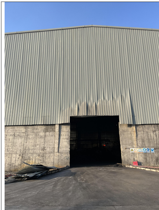
原煤库采用密闭厂房形式储库
