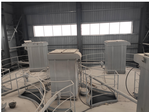
混凝土搅拌楼仓顶排放口
