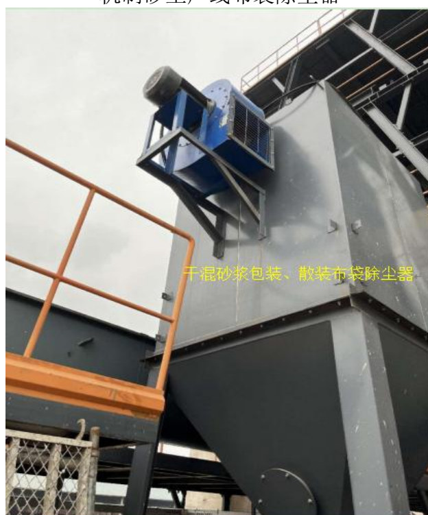
干混砂浆包装、散装布袋除尘器
