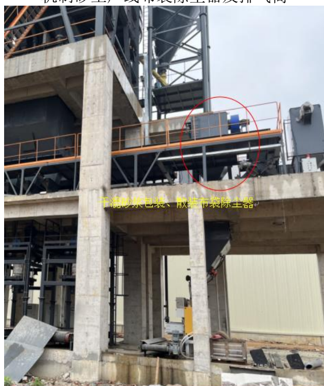
干混砂浆包装、散装布袋除尘器
