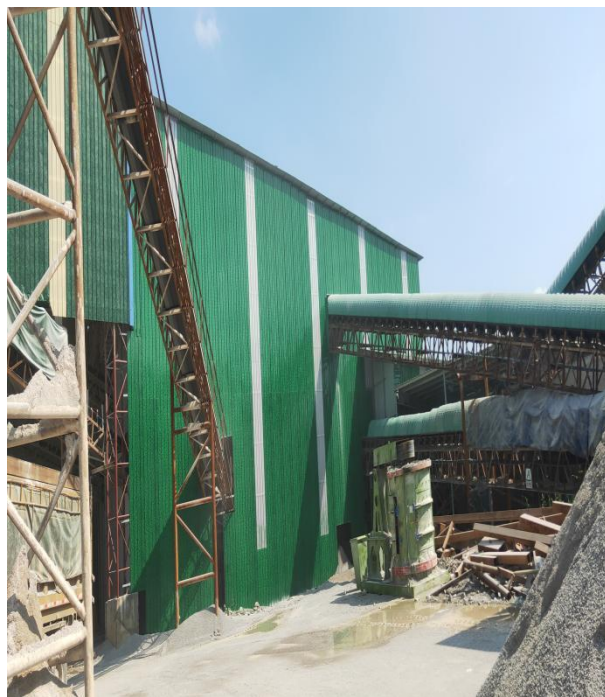
三面围挡和顶棚加盖
