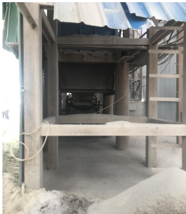
厂区及硬化地面
