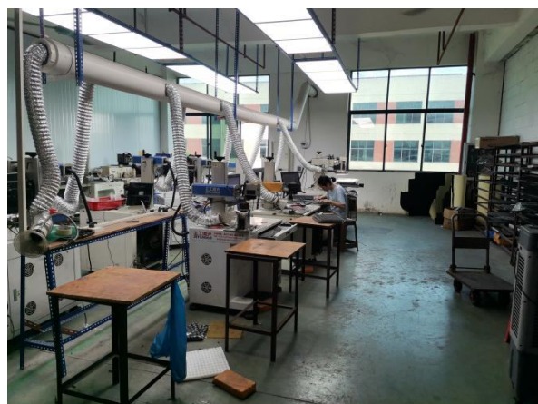
激光雕刻废气收集管道
