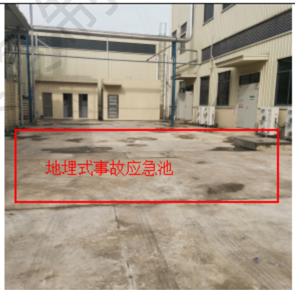
地埋式事故应急池
