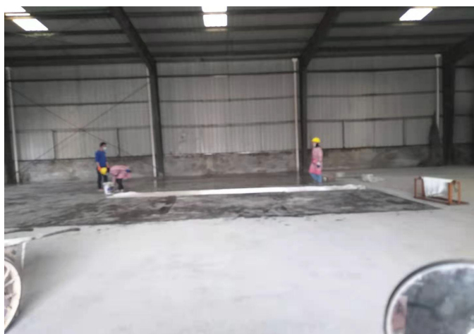
防腐防渗施工图片 3
