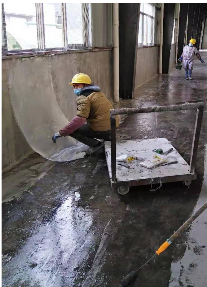
防腐防渗施工图片 5
