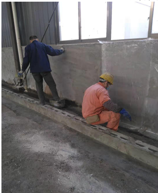
防腐防渗施工图片 1
