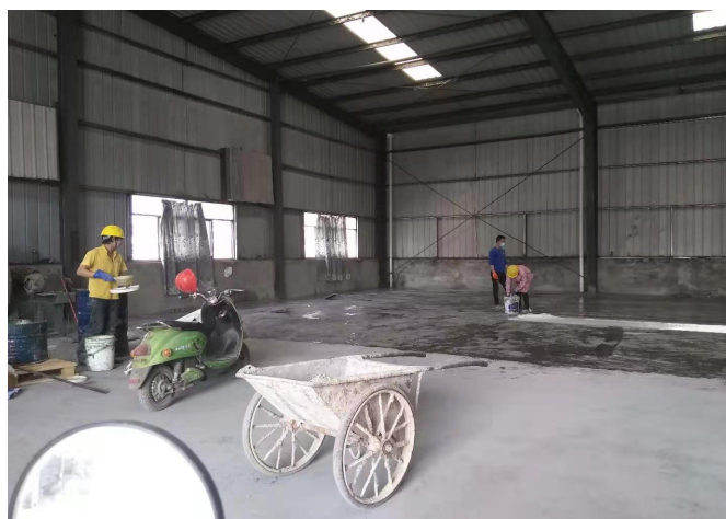
防腐防渗施工图片 4
