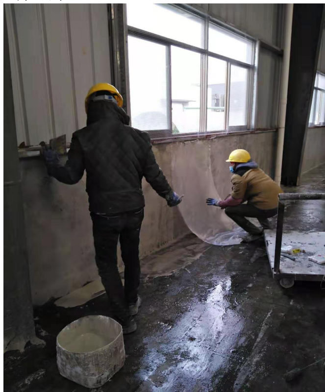
防腐防渗施工图片 2
