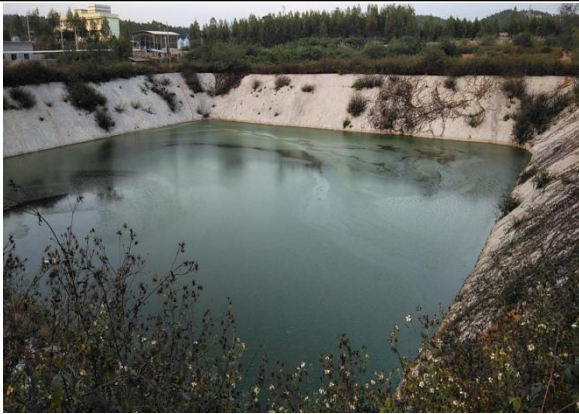
初期雨水池（兼应急池）
