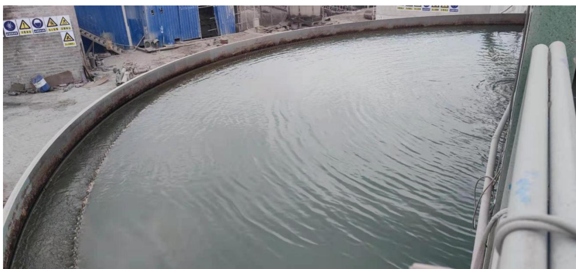
矿石清洗废水沉淀池 2
