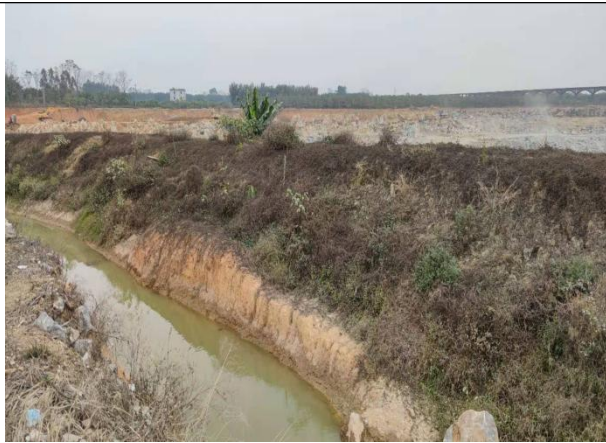
采矿区边界线修筑的防洪围堤并种植植被
