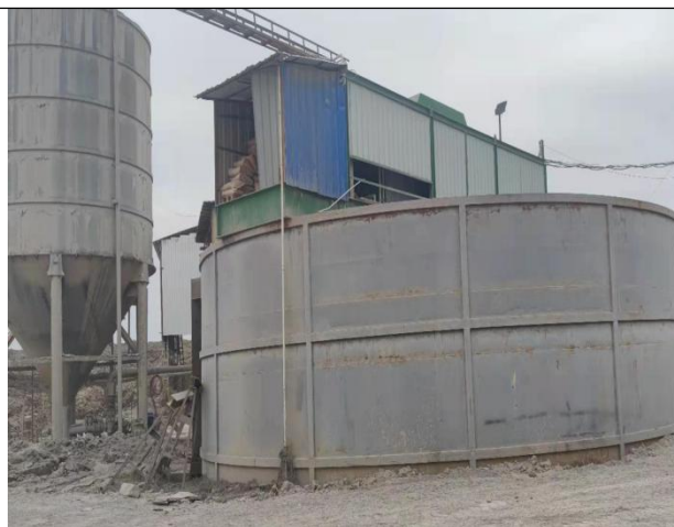
矿石清洗废水沉淀池 1
