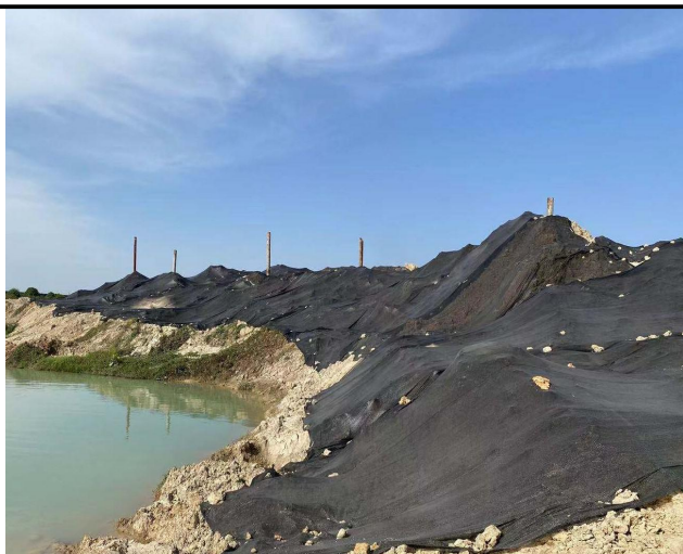
临时表土堆场加盖篷布
