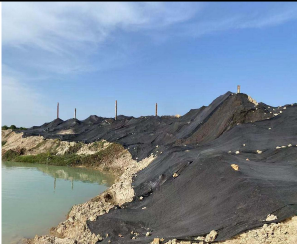
临时表土堆场加盖篷布
