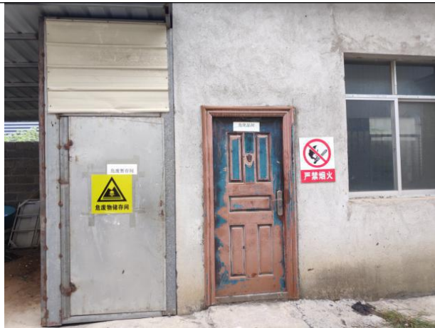
危废暂存间及危化品间（外部）
