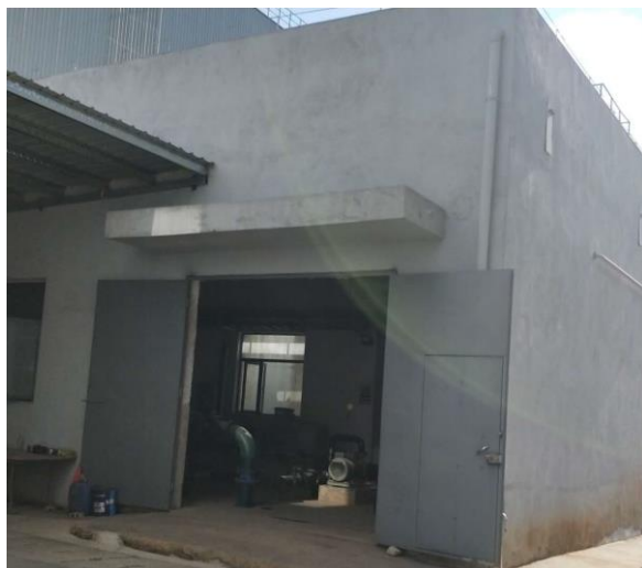
室内循环水泵房
