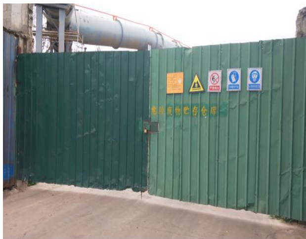
危险废物贮存仓库外部
