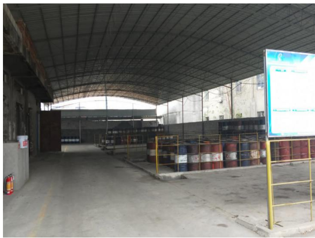
危险废物贮存仓库内部
