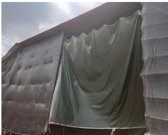
破碎车间围挡
