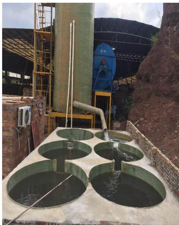
脱硫除尘循环水池
