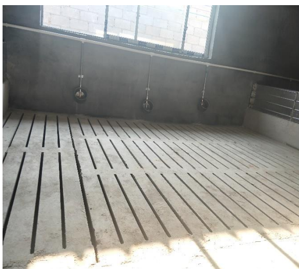
猪舍漏缝排粪区+“鸭嘴式”饮水不漏水系统
