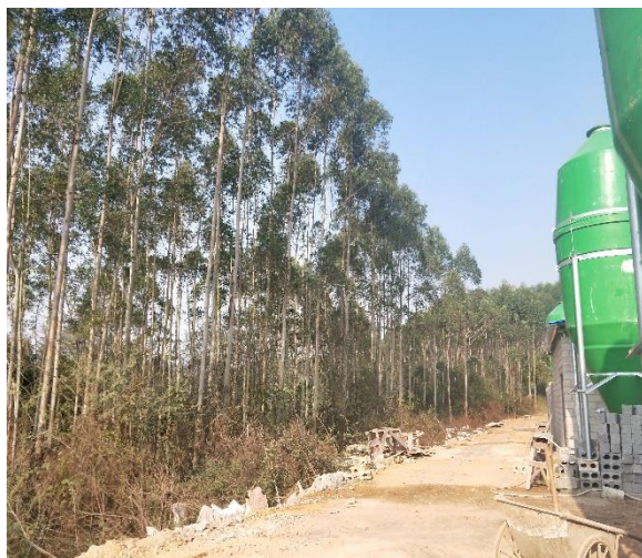
周边林地 + 饲料储存罐
