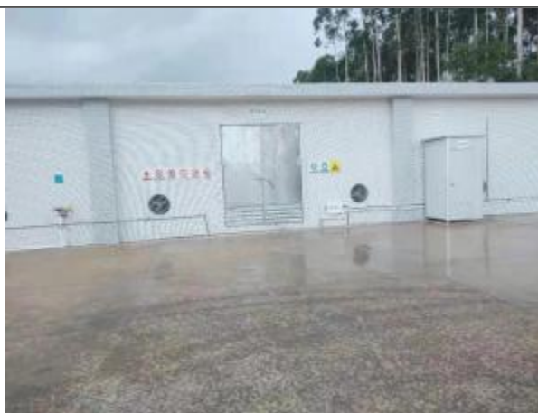
危废暂存间外部
