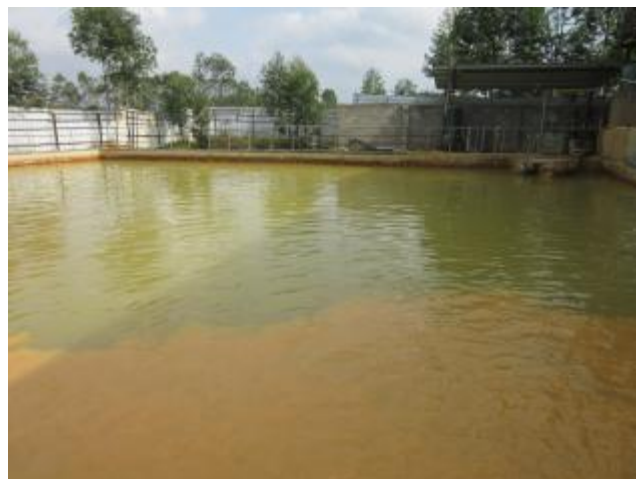
含酸废水二级沉淀池
