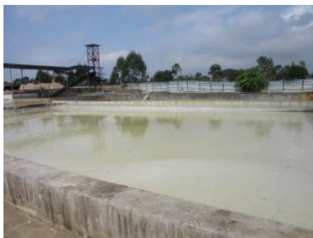
含酸废水一级沉淀池
