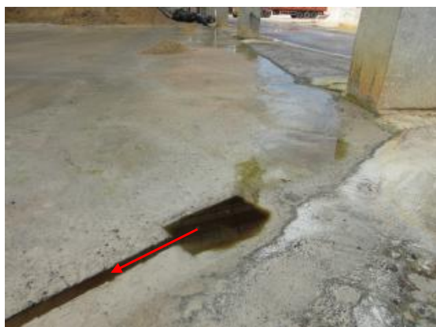
喷酸区内含酸废水收集
