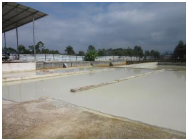
洗矿废水三级沉淀池
