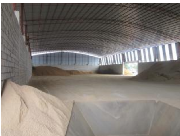
原料堆场加盖厂棚、水泥硬化地面
