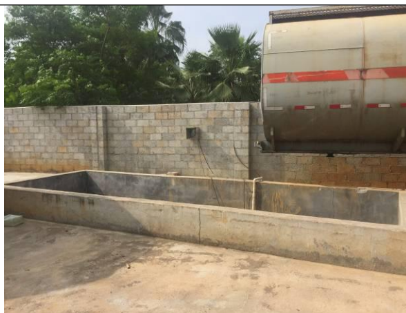
厂区初期雨水池
