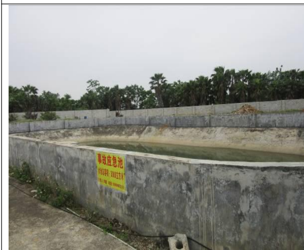
事故应急池（3000 立方）
