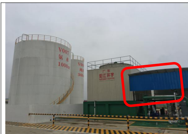
氨尾气回收塔
