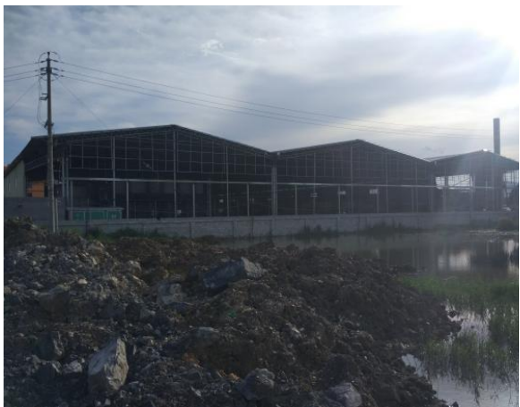
拟建项目西南面（中恒化工）
