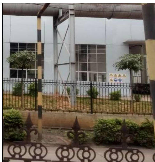
危废暂存间外部
