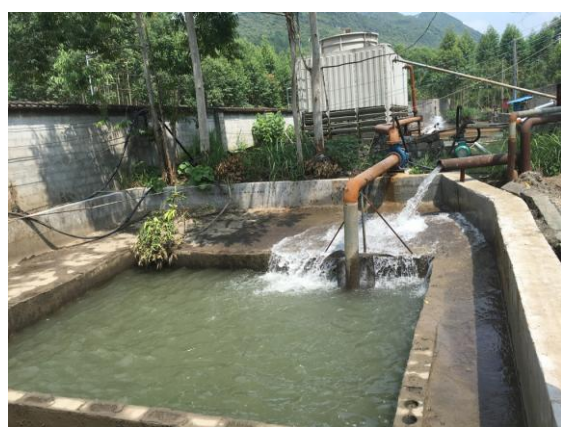
冲渣水沉淀循环回用池
