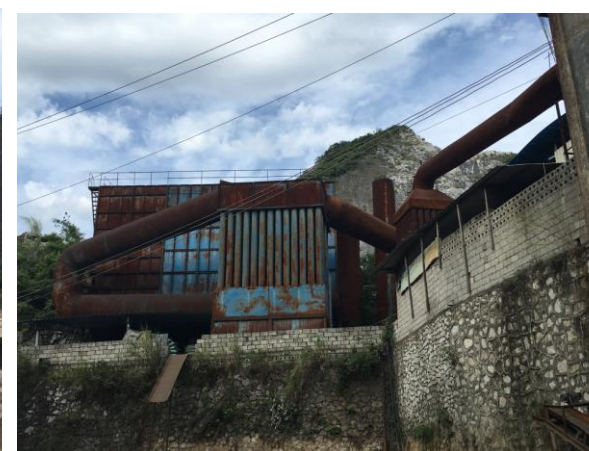
第二条生产线除尘装置（本期工程）
