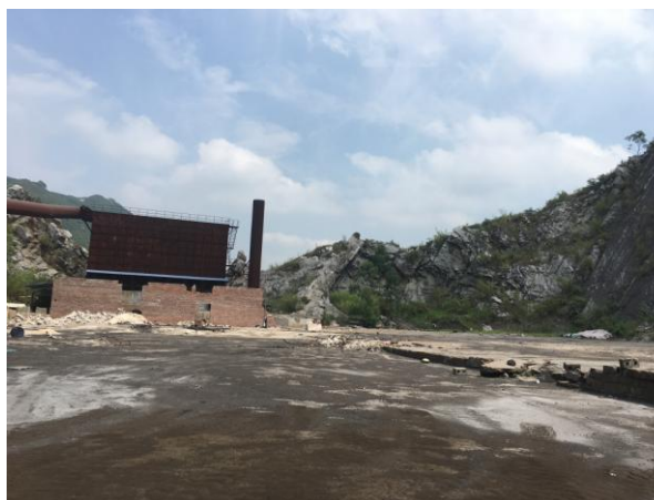
第一条生产线除尘装置
