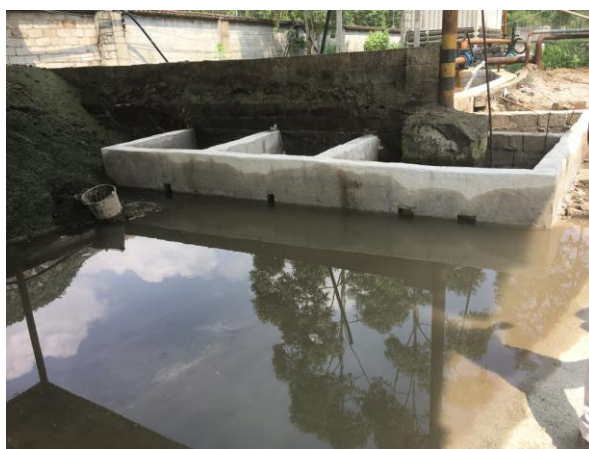
水淬渣滤出水收集池
