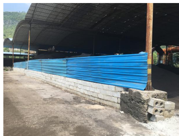
原料堆场围栏、防雨顶棚
