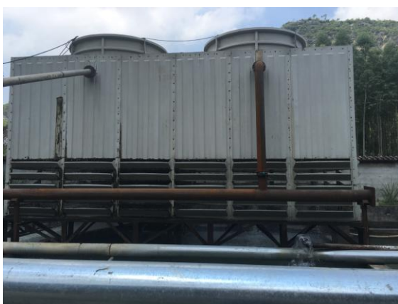
冷却水冷却塔
