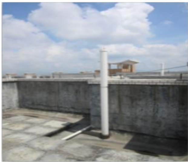
位于楼顶的发电机废气排放口
