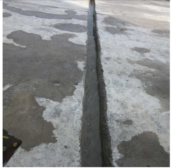
项目场地雨排水沟
