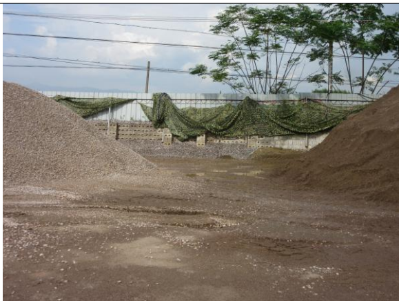
项目原料堆场围挡
