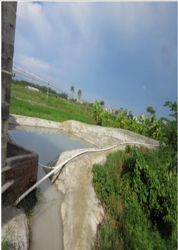
三级沉淀池导流渠
