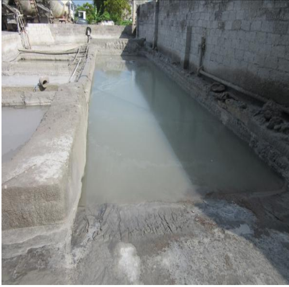
车辆清洗废水沉淀池
