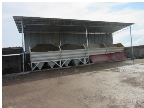
下料口及围挡围墙
