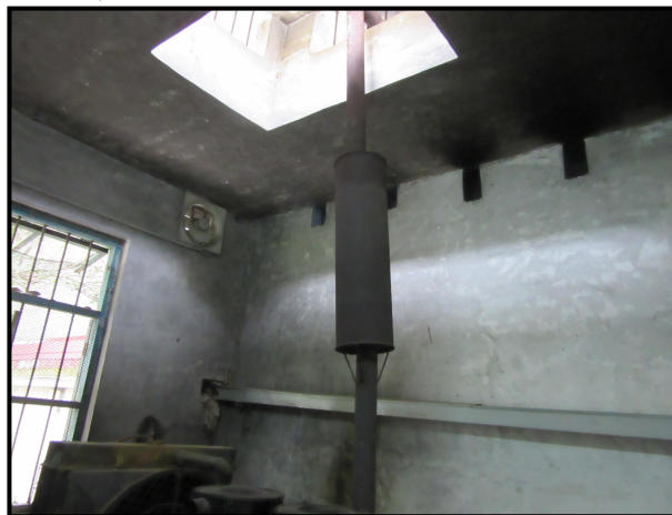
应急柴油发电机排烟管
