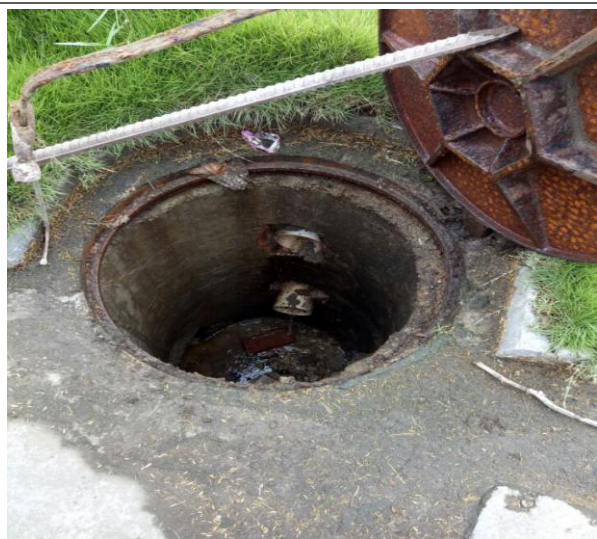
生活污水排放口
