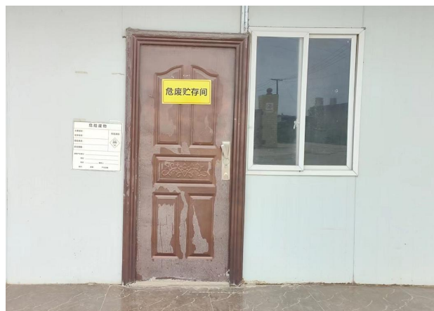
危险废物暂存间
