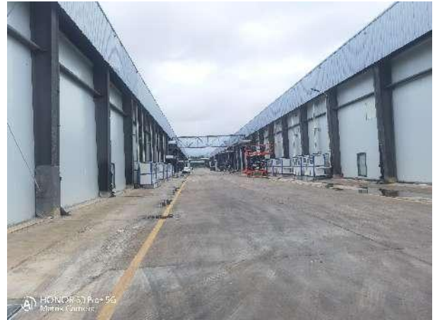
厂区整体现状
