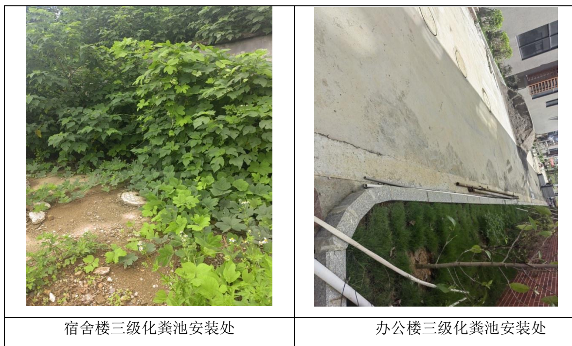
图 3-2 三级化粪池地面现状图
