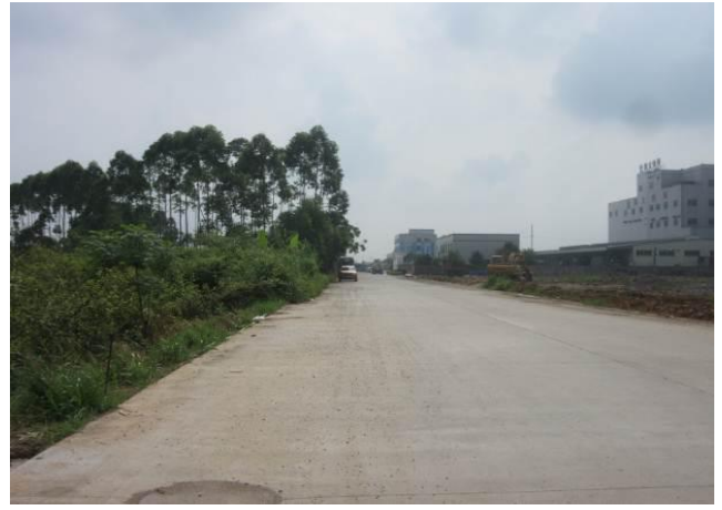
项目北面的园区道路（进港二路）
